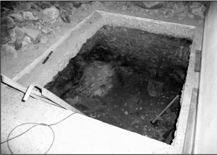
Encuentro con el pedernal que trajo de cabeza a los intrépidos trabajadores en los inicios de la obra del ascensor.
