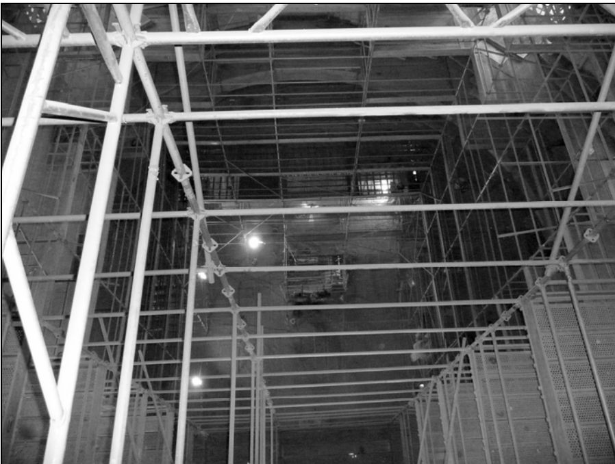
Dos imágenes del espectacular andamio empleado en la restauración de la cúpula.
