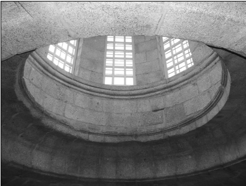
Anillo que cierra la cúpula. Sobre él se eleva la linterna.
