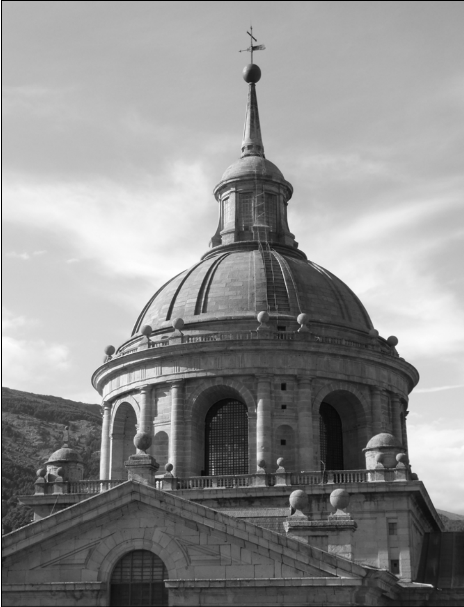
Vista externa del cimborrio. Puede apreciarse el tambor, la cúpula de media naranja (achatada), la linterna, la espiga, la bola, la veleta y, rematando, la cruz.
